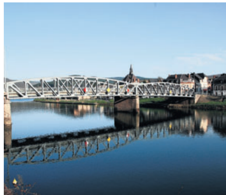
Brug over de Maas bij Haybes.
